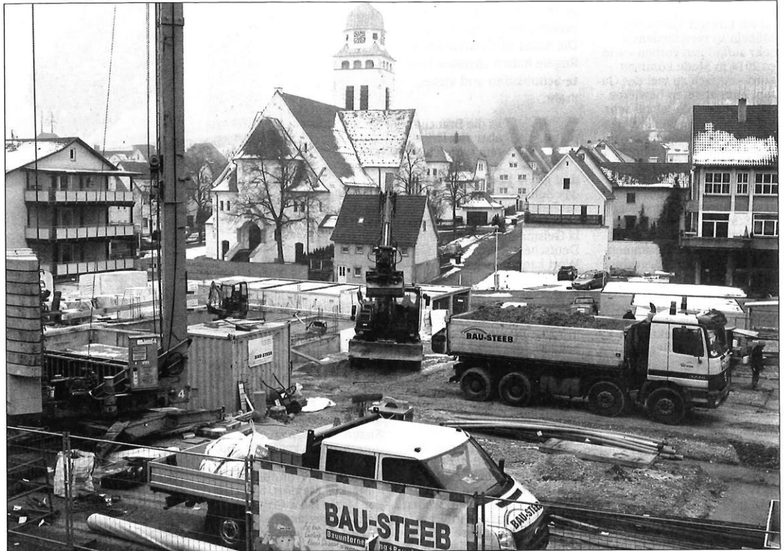
Baustelle im Herzen Tailfingens: Die Technologiewerkstatt soll dem Wirtschaftsleben Albstads neue Impulse geben.
